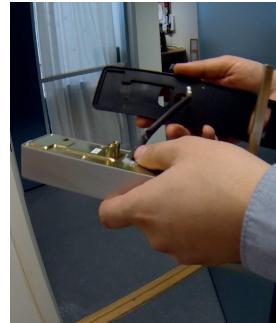
Det medföljer även ett utbyggnadsbeslag på 2mm som man måste använda om avståndet mellan låshuset och slutblecket blir för stort så att hakregeln inte automatiskt slår ut när dörren stängs.
