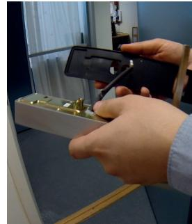
Det medfølger også et utbyggingsbeslag på 2mm som man må benytte om avstanden mellom låsekasse og sluttstykke blir for stor slik at låsekassens hakereile ikke automatisk slår ut når døren lukkes.
