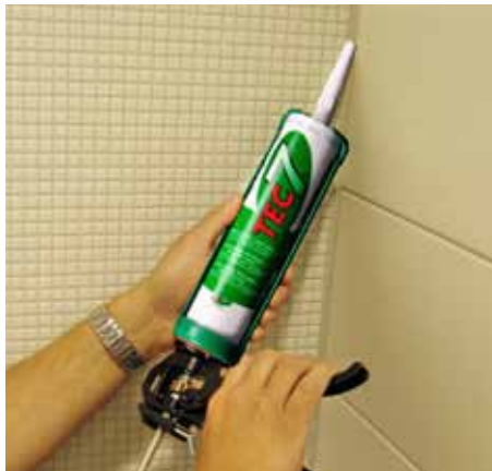
Legg på fugen – en fugepistol med høy utveksling, f.eks TecGun, gir best resultat
