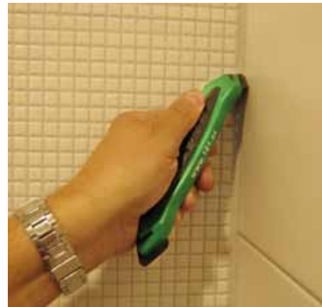
Bruk gjerne en fugeglatter, f.eks 101 Fugeglatter, for å jevne ut overflaten på fugen. Hvis du sprayer Tec7-Cleaner eller HP7 på fugen før glatting vil dette gjøre selve glattingen enklere, da massen blir mindre klebrig.
