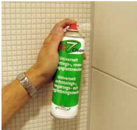
Rengjør området som skal fuges med f.eks Tec7-Cleaner
