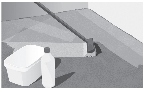
Fig. 7. Rengjør gulvet og påfør grunning.
