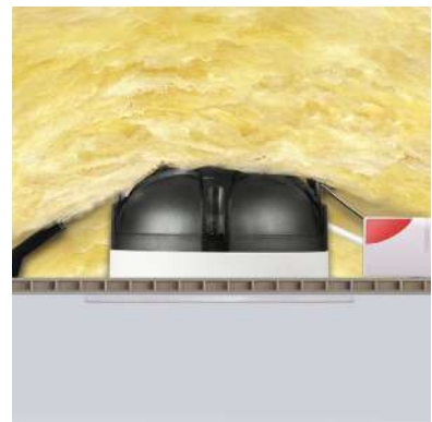
...og overdekket av isolasjonsmatter.
